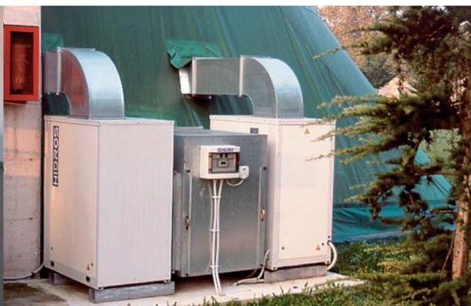
Sistema di deumidificazione e riscaldamento di una tenso struttura sportiva; effettuato tramite due deumidificatori modello ITM330S, capacità 13 l/h totali, equipaggiati di batteria ad acqua calda da 10 kW. Portata aria totale 7600 m<sup>3</sup>/h. Data installazione: Febbraio 2002.
